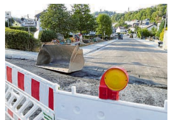
Der vierte Bauabschnitt in der Brunhildestraße ist früher fertig als geplant. FOTO: EVELYN KREUTZ
