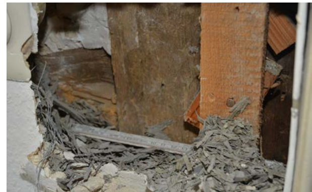
Abb. B 11: Befund 9, Brustriegel am Türpfosten R2, auf der Gegenseite schloss kein Riegel an.
