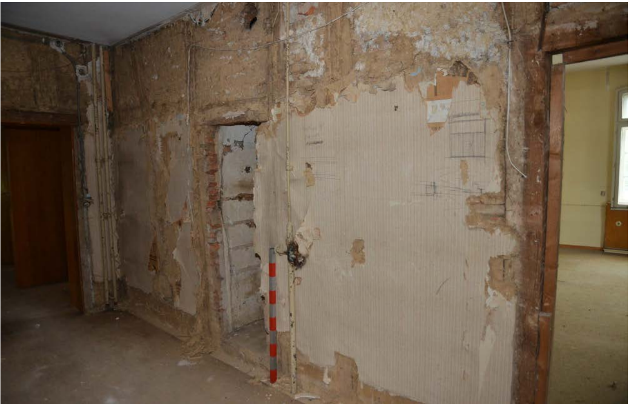
Flur 2, Ostwand zu Saal und Zimmer 4, mit Ofennische.
