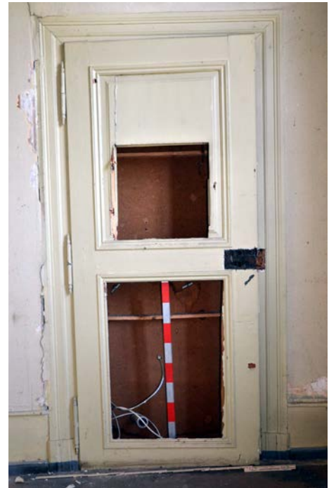
Tür zu R1 mit Sockellambris.
