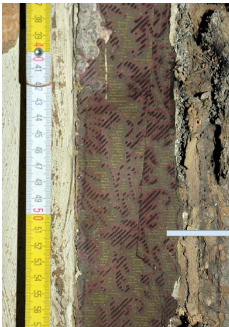
Zimmer 4, älterer Tapetenrest auf einem Brett, das man zum unterfüttern des Türrahmens benutzt hat, (vgl. Tapete EG R3).
