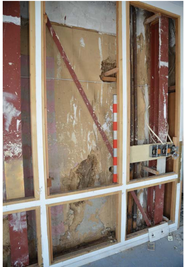
Abb. B 6: Befund 4, mittleres Wandfeld mit Geschossstrebe
