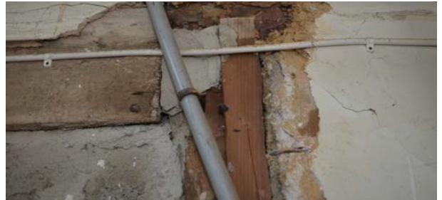
Abb. B 3: Ausschnitt Befund 2: Rest der Tüfutter mit geschmiedeten Nägeln
