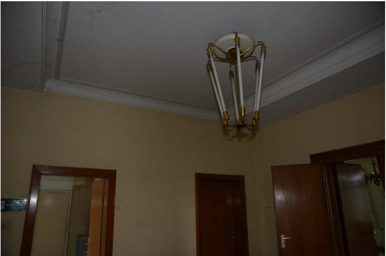
Treppenhaus OG, der Deckenspiegel gehört zur bauzeitlichen Fassung, Lampe 1950er Jahre.
