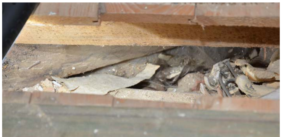
Zimmer 9, aufgedoppelter Boden, die Deckenbalken darunter liegen frei.
