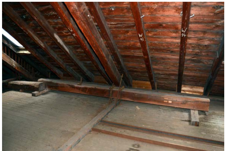
Mit mehreren Überzügen hat man versucht, Lasten zu verteilen.
