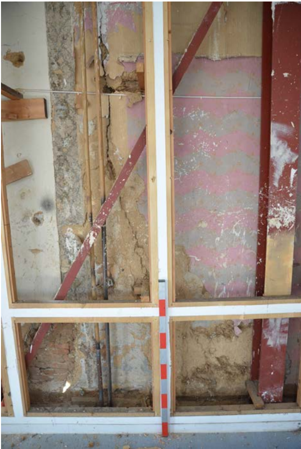
Abb. B 5: Befund 3, mittlerer Wandabschnitt mit stark gekrümmter Geschossstrebe. links neben den Heizungsrohren ein späterer Wandanschluss.
