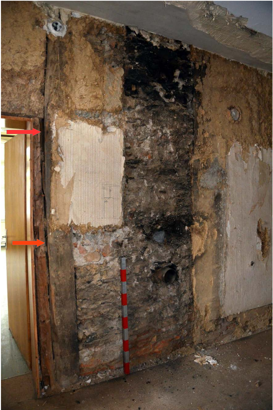
Flur 2, Westwand. an der Wand zeichnet sich deutlich der Standort eines Schornsteins ab.
