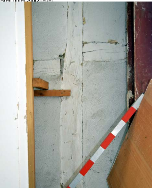
Abb. B 12: Befund 10, alter Wandpfosten in der Südwand R3, er weist zahlreiche geschmiedete Nägel auf.
