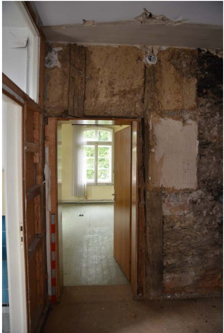
Flur2, Westwand, die Tür wurde später eingebaut.
