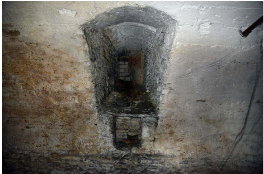
Nördliches Kellerfenster mit kleiner Mauernische.
