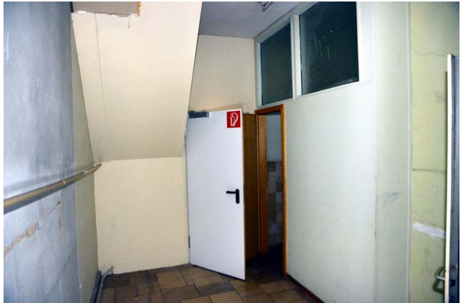
Flur DG, innerhalb der abgeteilten schmalen Kammer führte ehemals ein Schornstein durch.
