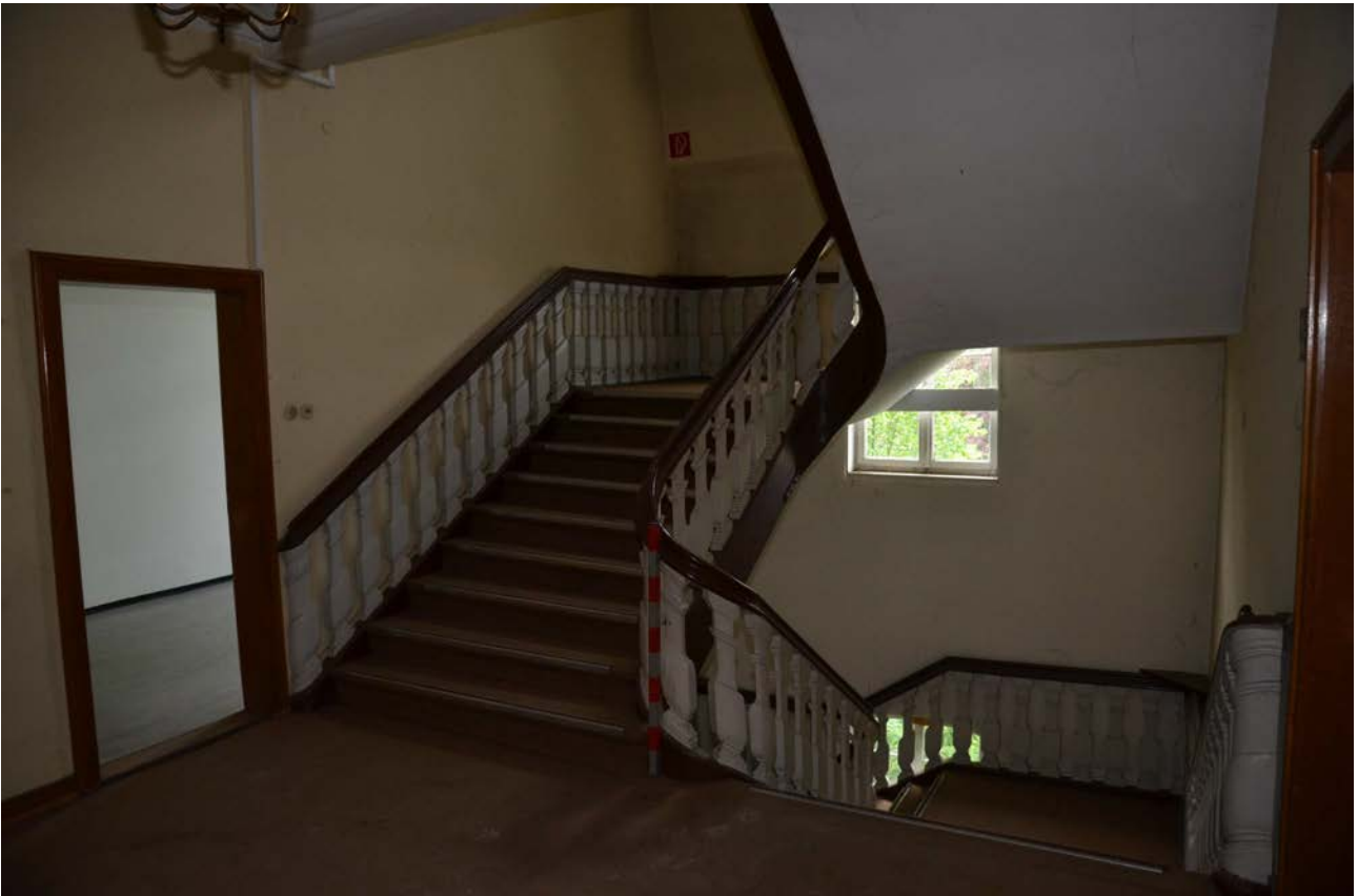
Die freitragende Podesttreppe ist ein hervorragende Zimmerarbeit und letztes Zeugnis für den barocken Innenausbau.
