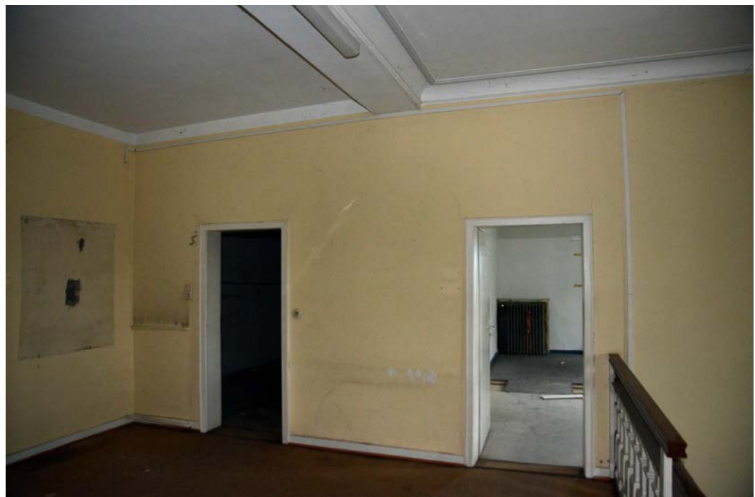
Treppenhaus Mansardgeschoss nach Süden.
