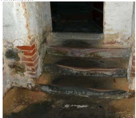
Treppe zum Hinterkeller.
