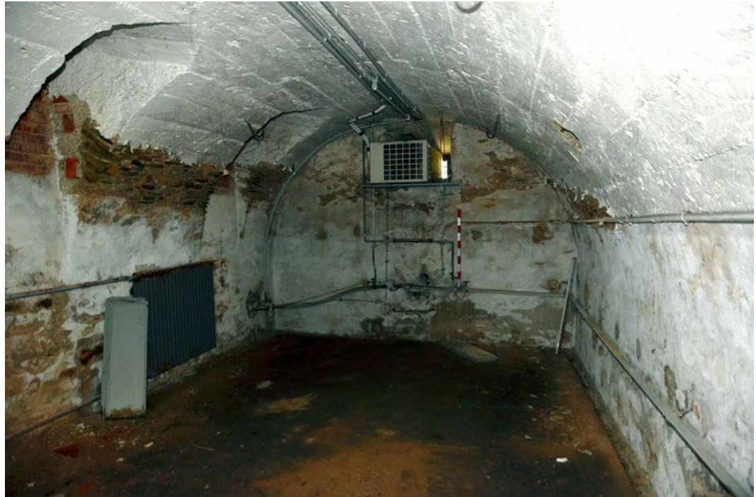
Südliche Hälfte des Kellergewölbes.
