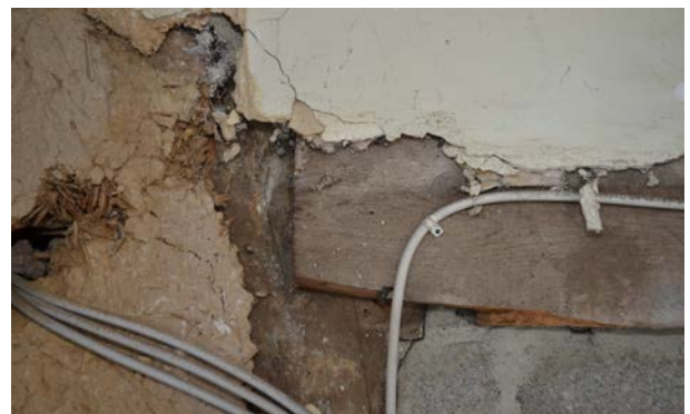
Abb. B 4: Ausschnitt aus B2: Türpfosten und Sturzbrett mit geschmiedeten Nägeln
