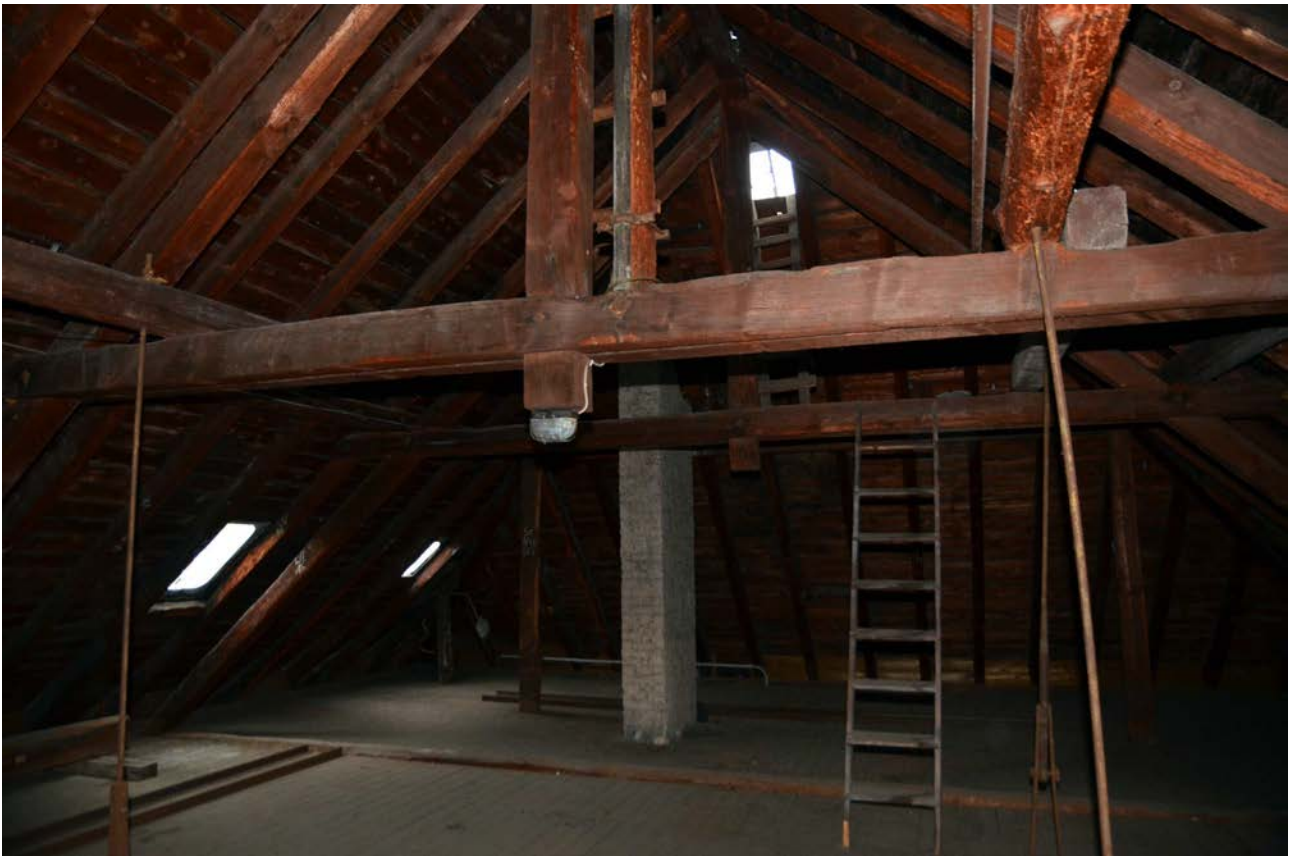
Das Dachwerk wurde komplett erneuert, der zuletzt genutzte Schornsteinkopf vorher abgebrochen.
