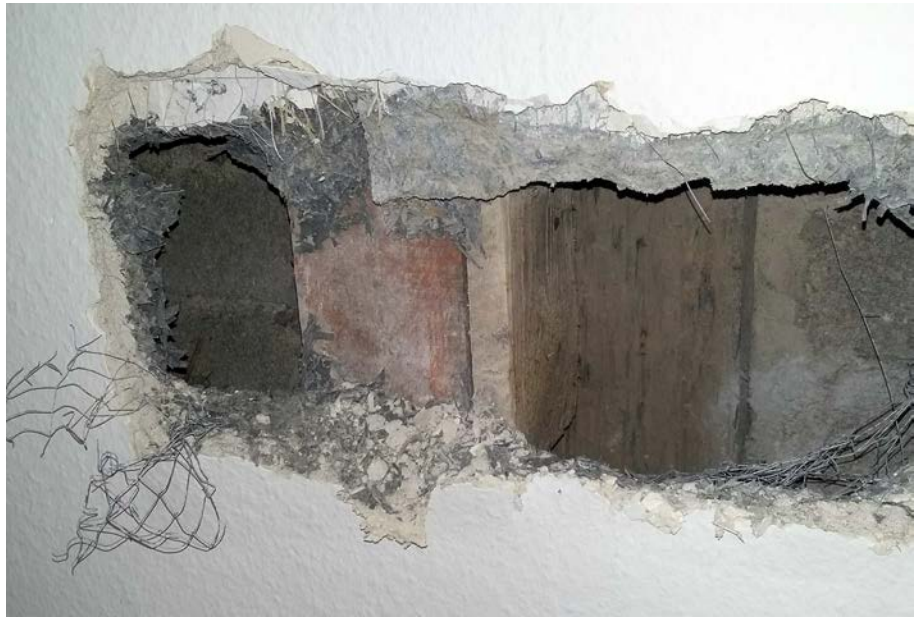
Raum 8, Nordwand. L-förmiger Wandpfosten, der vorspringende Teil ist mit Brettern verschalt.
