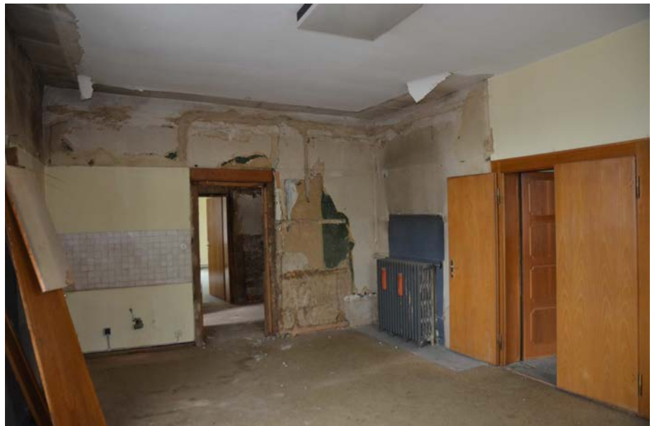
Zimmer 4, die Kubatur entspricht der Bauzeit, der Unterputz aus Lehm ist an der Wand zum Gang einsehbar, darüber verschiedene Renovierungsschichten mit Tapeten.
