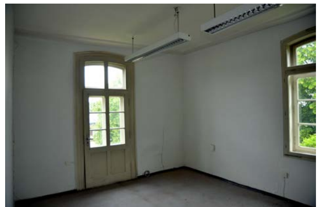
Zimmer 2, Nordwestl. Raumecke, Tür ehem. Übergang zum Anbau 50er Jahre.
