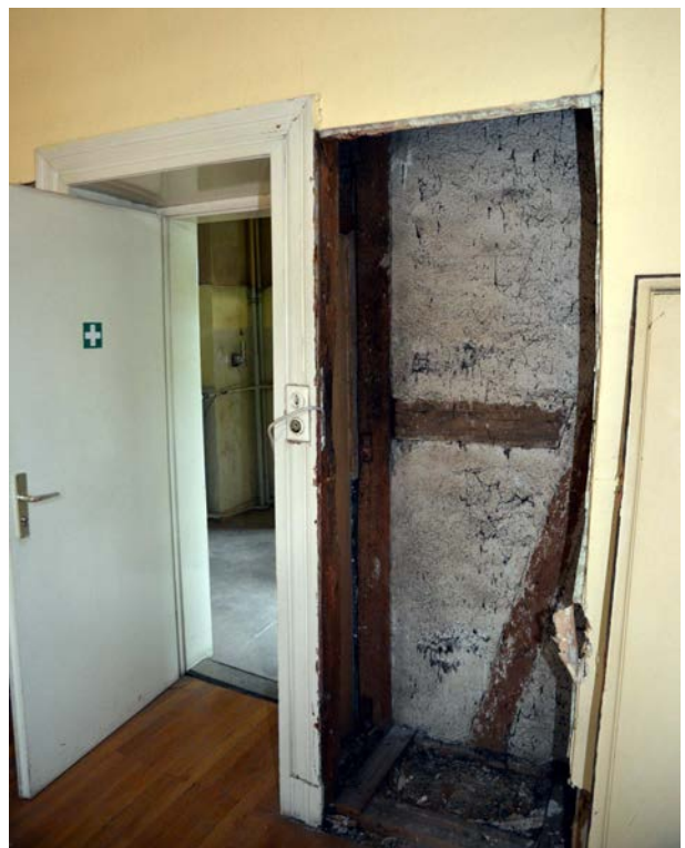
Zimmer 3, Hohlwand für ehemaligen Schrankeinbau.
