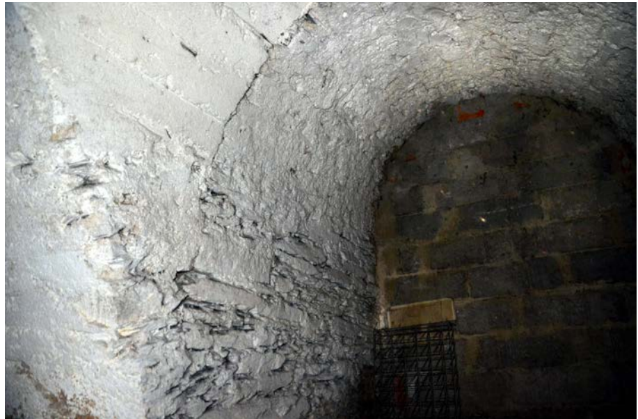
Ehemaliger Zugang von der Straßenseite, der unter der Haupttreppe austrat.
