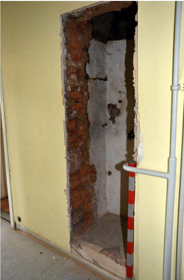
Flur 1, Ofenanlage in der Ostseite zu Zimmer 3.
