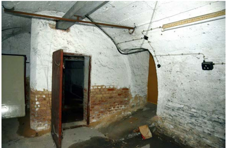
Luftschutzeinbauten vor Zugang zum Hinterkeller.
