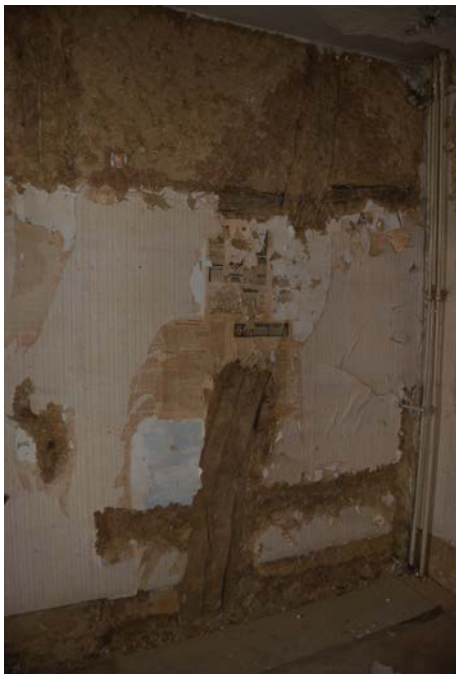
Flur 2, Westwand, vorderer teil zum Treppenhaus.
