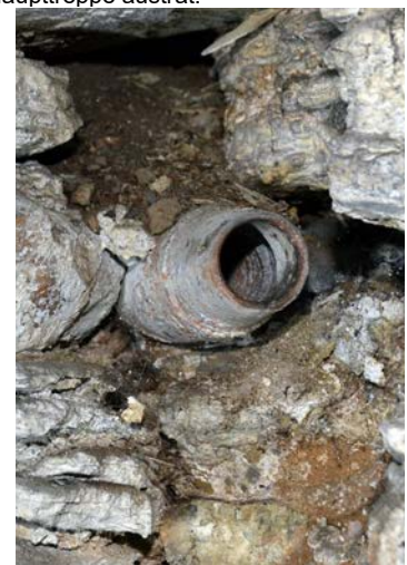
Alte Tonwasserröhre in nördl. Schildwand Hauptgewölbe.
