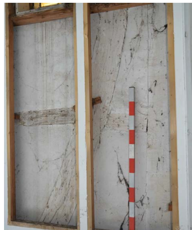
Abb. B 13: Befund 11, alte Strebe mit Riegel an der Westseite R3.
