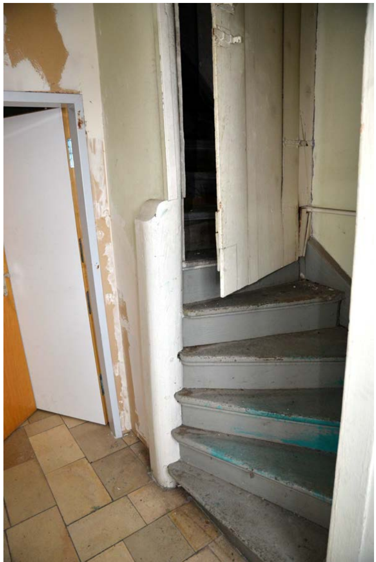
Flur DG, Treppe zum Dachraum.
