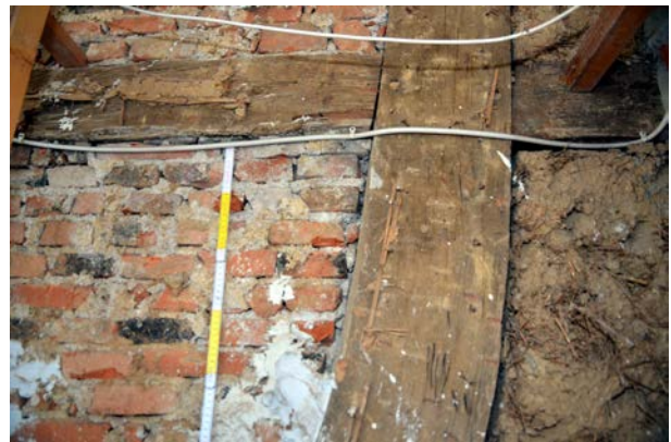
Abb. B 7: Befund 6, Wandabschnitt mit vernagelten Riegeln an Geschossstrebe.
