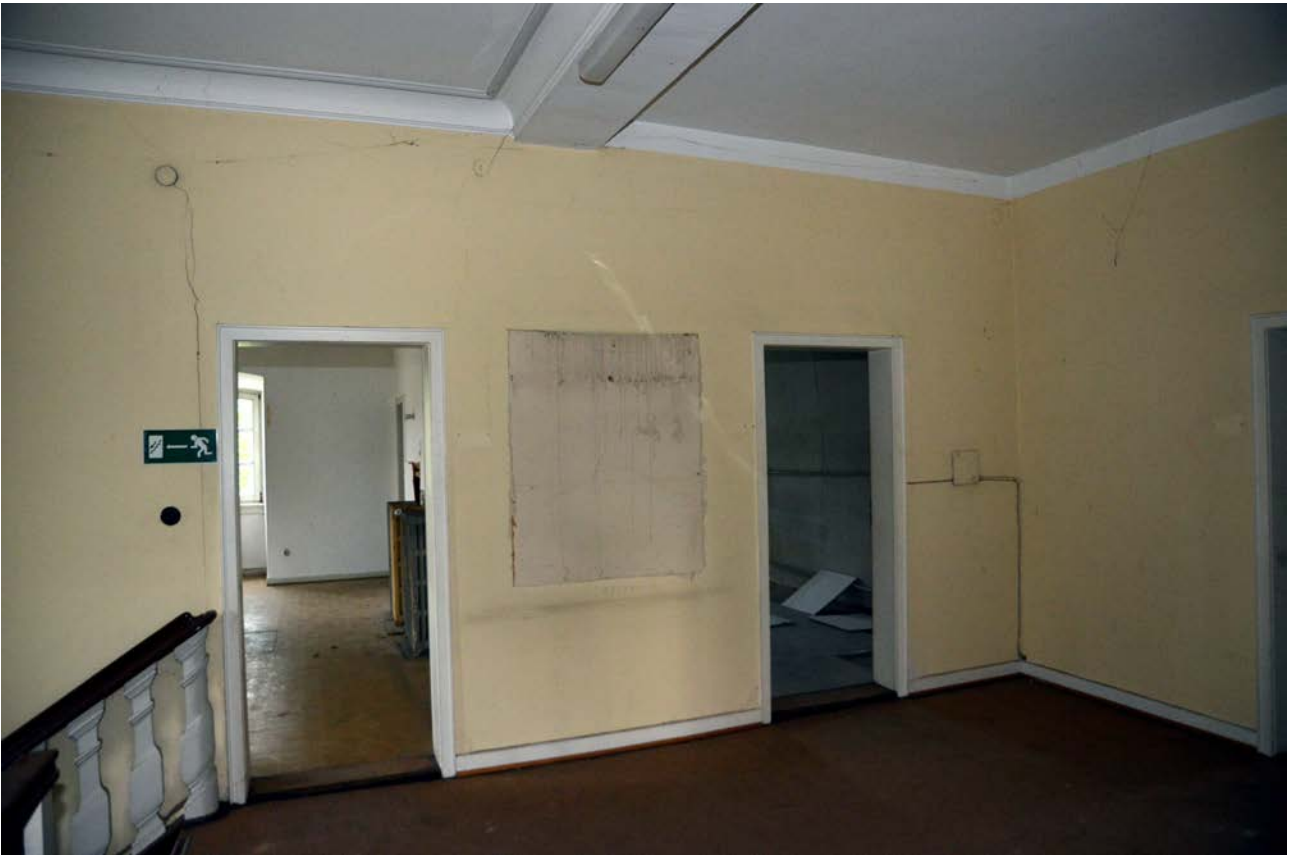
Das Treppenhaus öffnete sich bis zum Mansardenfenster an der Straßenseite, die Wand rechts wurde nachträglich eingezogen
