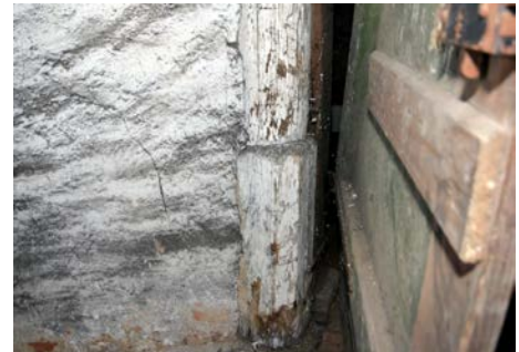
Stützenfuß (Foto oben)
