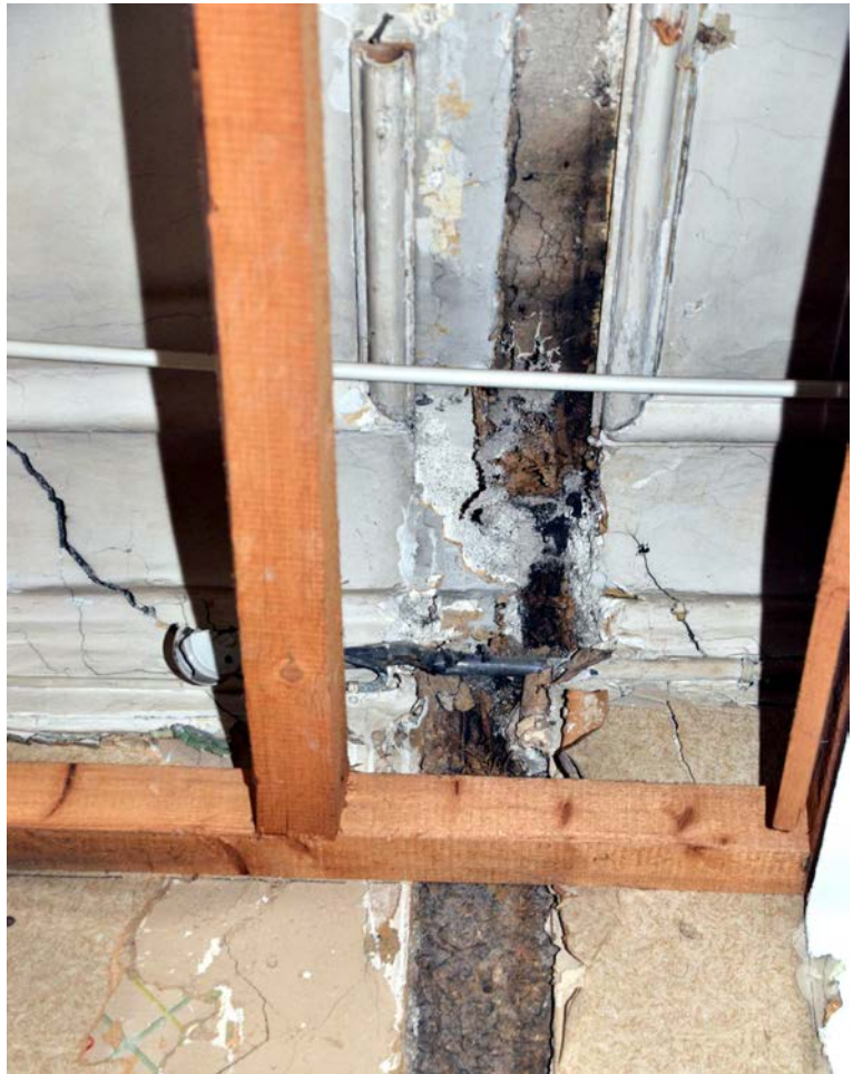
Zimmer 1/2, Ostwand, Abdruck einer frühen Zwischenwand, vor Umbauzeit um 1900. Ergänzte Profile sind aus Holz.
