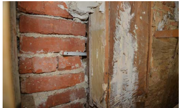
Abb. B 10: Befund 8, Zapfenloch Brustriegel am ausladenden Wandpfosten.
