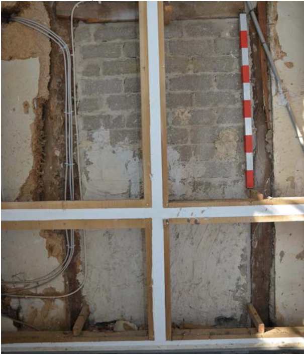
Abb. B 2: Befund 2. Die zugemauerte Tür gehört zum ältesten Bestand.
