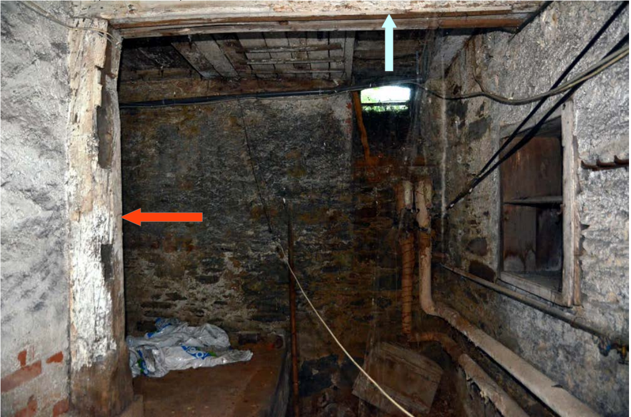
Hinterer Keller, nördlich der Treppe nach Westen. Spolie zur Stütze eines Unterzugs.
