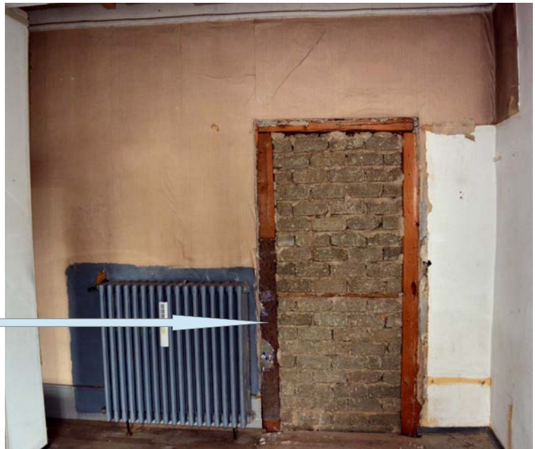
Zimmer 4, vermauerte Tür zum Flur; die Tür ist nicht bauzeitlich.
