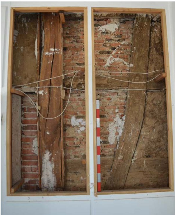
Abb. B 8: Befund 5, Wandabschnitt unterschiedlichem Füllmaterial.
