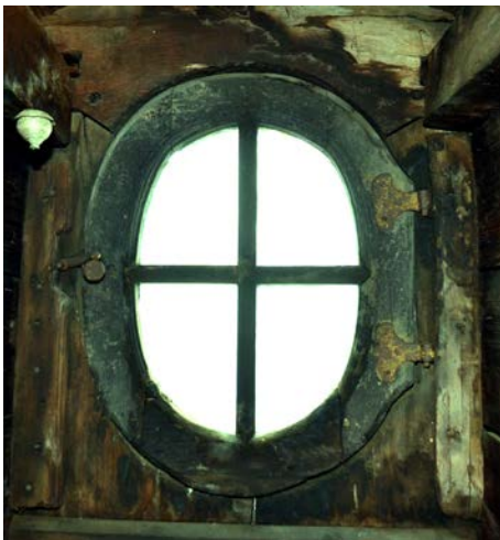
Die drei vorhandenen Gaubenfenster wurden mit Rahmenhölzern wieder eingebaut.
