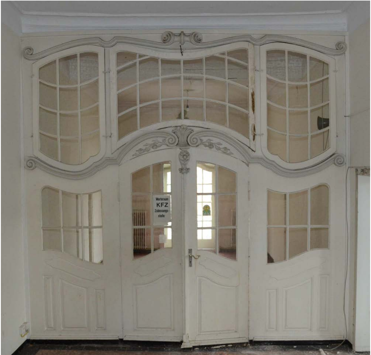
Befund R 1, 1:Windfangtür Innenseite
