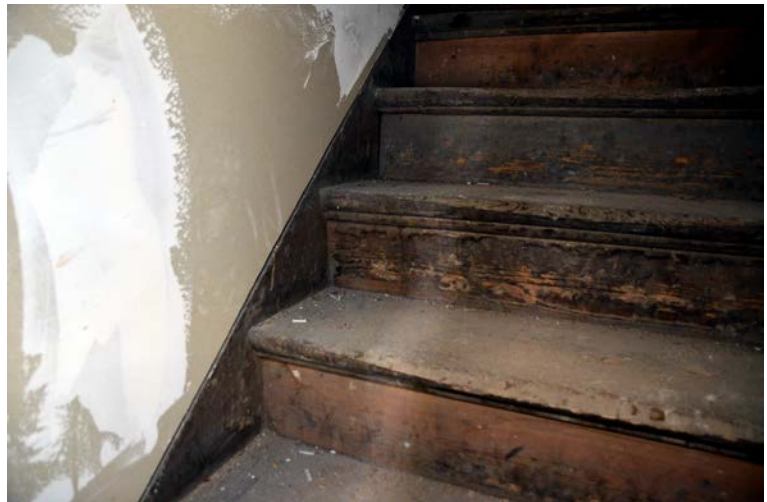
Kellertreppe, die Ausführung entspricht der Treppe vom Mansardgeschoss zum Dachraum.
