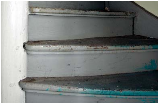
Treppe zum Dachraum.
