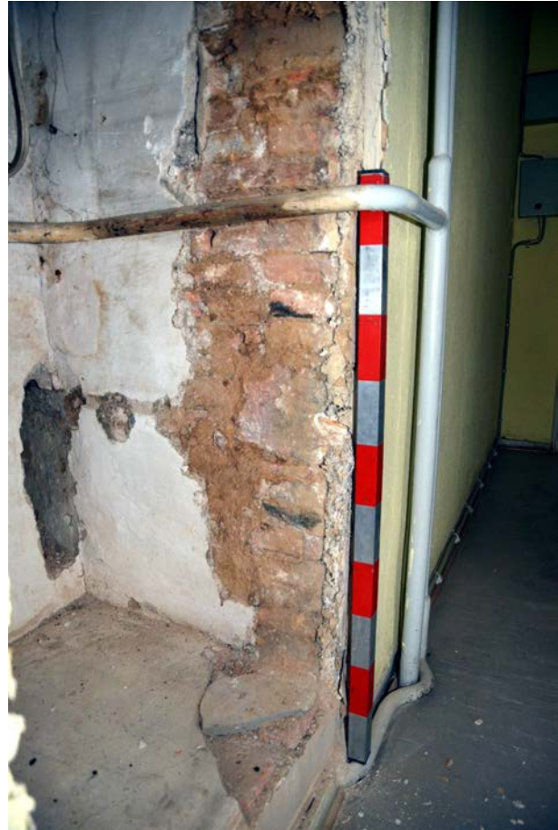
Flur 1, Detail Ofenanlage, Kante mit barocken Ziegelformaten, schräg gestelltem Kämpferziegel und Werkstein in Höhe der ehemaligen Verriegelung.
