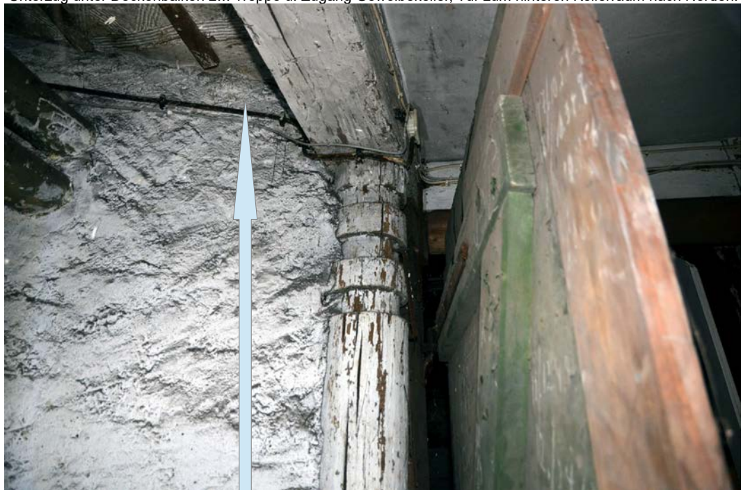
Rundstütze unter Unterzug (Foto oben).
