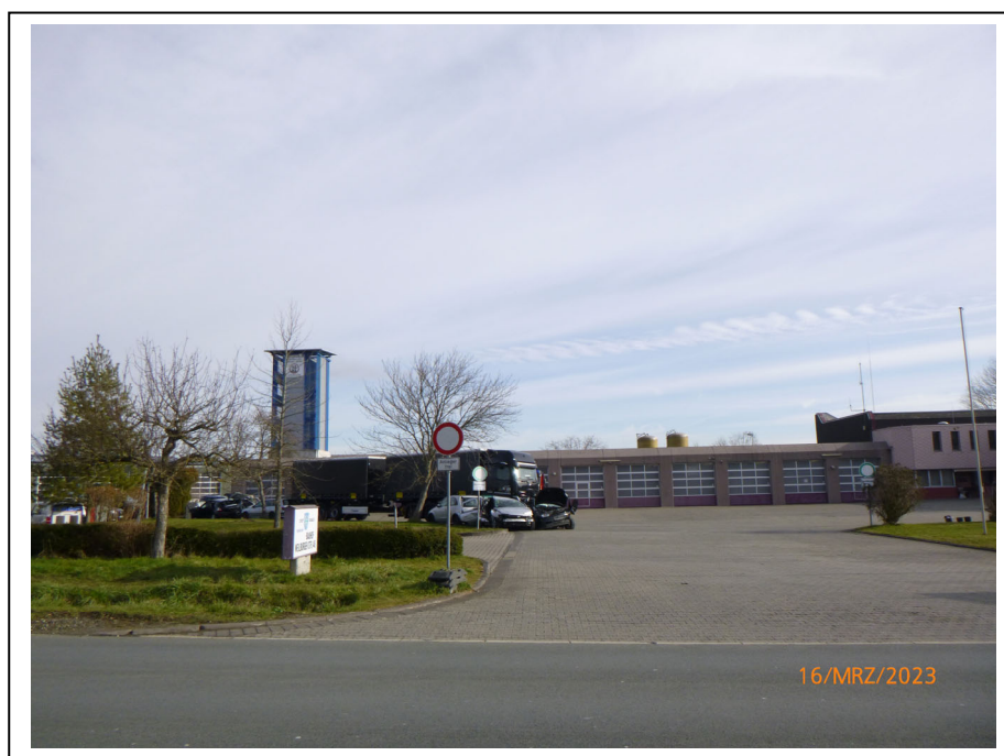
Bild Nr. 1: Blick auf das bestehende Feuerwehrgebäude; Übersichtsaufnahme
