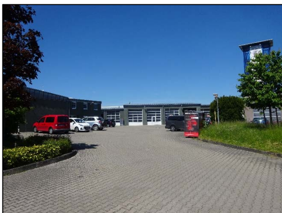
Abb. 7: Blick nach Norden auf das Gelände des Bauhofs (Aufnahme 05/2023).
