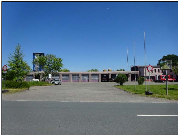
Abb. 5: Blick nach Norden auf das Gelände der Feuerwehr (Aufnahme 05/2023).
