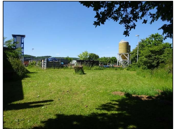
Abb. 12: Vielschnitttrassen im Nordosten des Plangebietes. Blick nach Norden (Aufnahme 05/2023).
