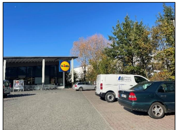
Abb. 12: Bestandsgebäude sowie gepflasterte und asphaltierte Stellplatz- und Verkehrsbereiche (eigene Aufnahme 10/2024).
